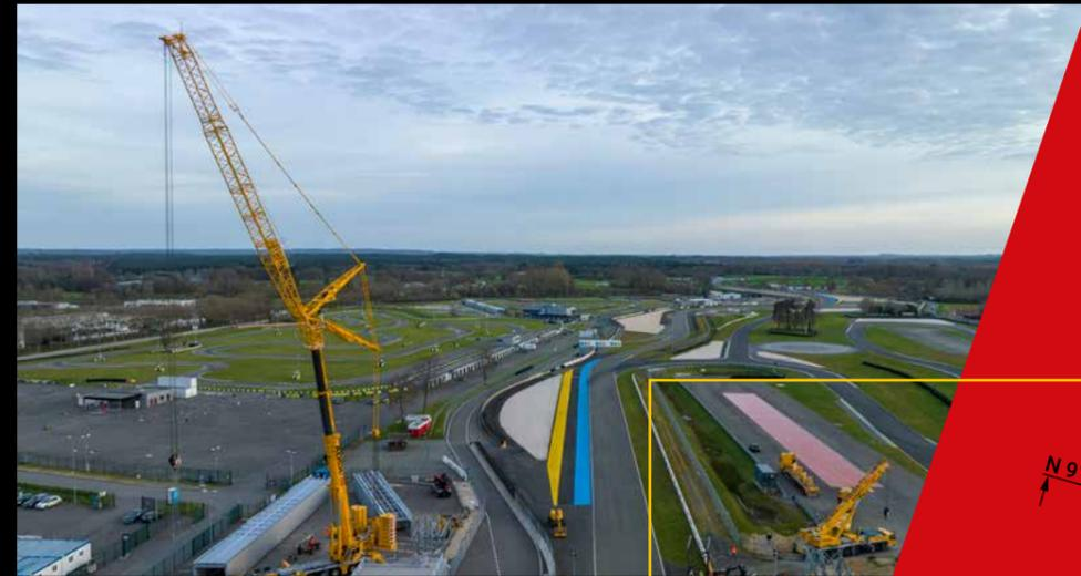
Dotée de deux versions de flèches télescopiques différentes (54 ou 80 mètres), d'un haubanage, mais aussi d'un système de volée variable et d'une fléchette, elle permet d'atteindre des **portées allant jusqu'à 112 mètres** et des **hauteurs de travail jusqu'à 156 mètres**.
